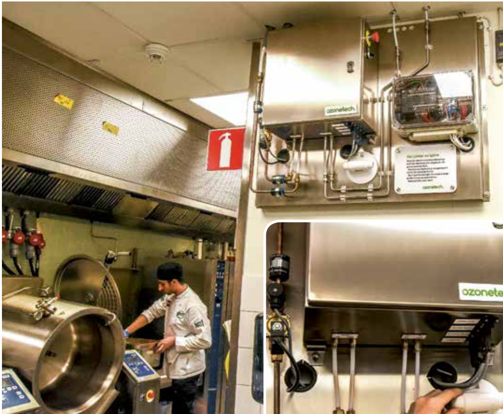
I den vita plasten (bilden t. h.) sitter en av två ozondetektorer som kontrollerar att inget ozon kommer på villovägar.
